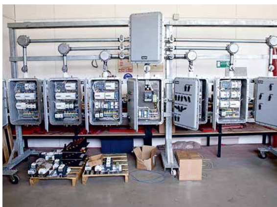
Электромонтаж между отдельными устройствами
